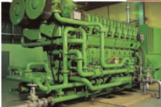
موتور ژنراتور یک نیروگاه برق اضطراری معدن
